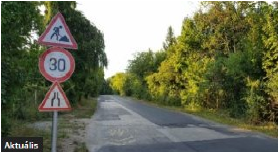
6. ábra – Budaligeti út aszfaltozása
